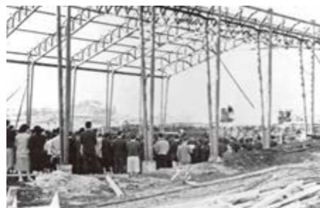
■ 旧チャペル上棟式 (1958年7月) 1958年7月、旧チャペルの建設が着工された。
