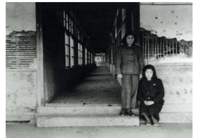
■ 壁が落ちた校舎（1950年頃） 当初の校舎は、壁が落ち、窓は破れており、安三は「オンボロ校舎」と呼んでいた。
