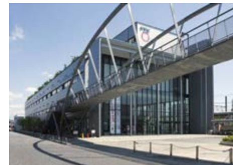
■ PFC と桜美林橋（2003 年） 駅のペディストリアンデッキとPFCを繋ぐ桜美林橋が架けられている。
