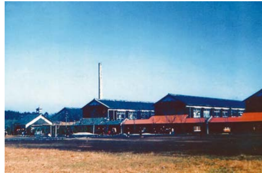
■ 木造の旧校舎（1953-56年） 木造2階建ての5棟の教室・宿舎からなっていた。
