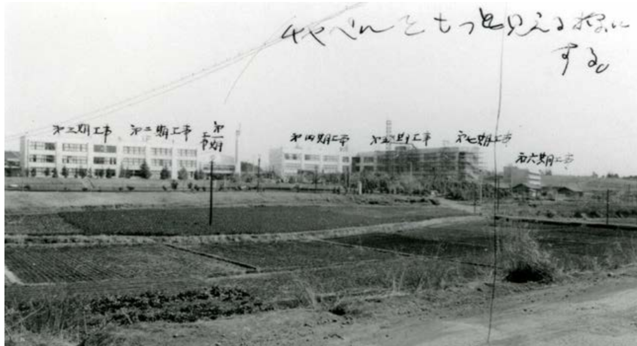
■ 第7期新校舎工事（1964年） 第7期工事として、学而館の第2期工事が行われた。学而館は2006年解体。
