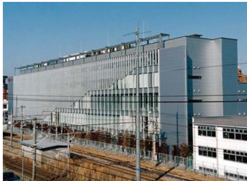
■ PFC 外観（2003 年） 横浜線線路沿いに建設された、地上4階、地下1階の建物で、約9,000㎡ある。
