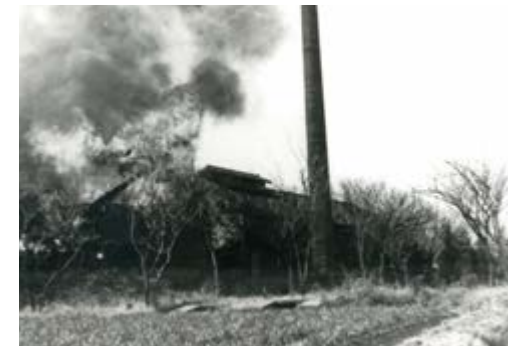
■ 旧校舎の火災（1958年3月8日）
