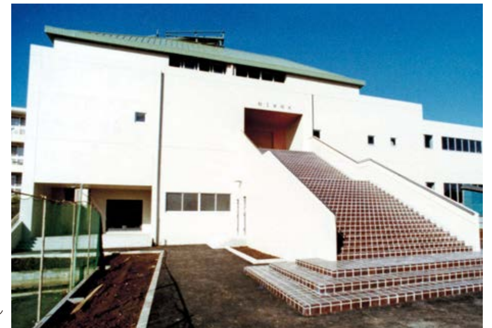
■ 又賜体育館竣工（1980年12月） 鉄骨3階建てで、床暖房用のソーラーシステムが導入された。
