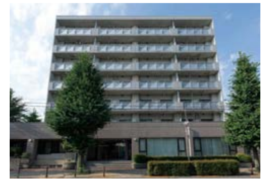
■ 第二国際寮（PFC III）外観（2013年） ワンルームタイプ定員84名の7階建て施設で、淵野辺駅南口にある。
