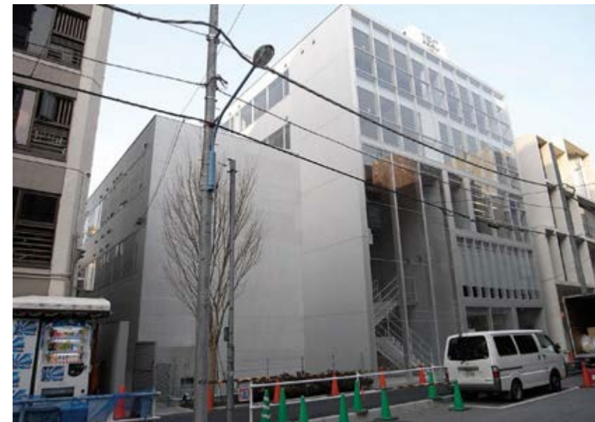
■ 竣工直前の四谷キャンパス（2008年3月） 四ツ谷駅近くに、地上5階、地下1階建ての校舎が建設された。
