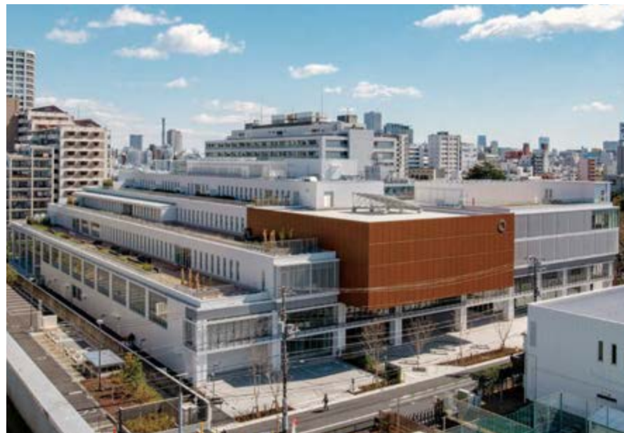
■ 新宿キャンパス(百人町)外観(2019年) 大久保駅・新大久保駅の近くに立地するこの創新館は、5階建て約1万6,500㎡の建物である。キャンパス各所が実践的な学びの場となっている。
