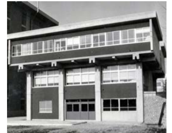
■ 本部棟竣工（1971年3月） 図書館の並びに建設され、後にメディアセンターとしても使用された。
