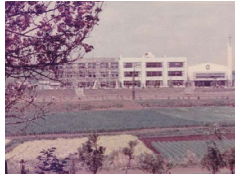
■ 明々館第2期工事中の様子（1960年3月）
